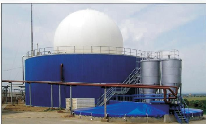
tlakem vzduchu vháněného mezi jednotlivé membrány. Pro minimalizaci koncentrace H<sub>2</sub>S v bioplynu je instalováno odsířovací zařízení, pracující na principu oxidace H<sub>2</sub>S sínými bakteriemi ve vodním prostředí na elementární síru.
